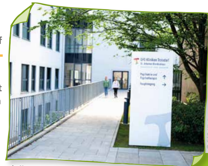
In Sieglar wurde mit einem Neubau auf einer Fläche von über 7.000 m², verteilt auf vier Stockwerke sowie ein Untergeschoss, ein moderner Raum für wohnortnahe, ambulante und stationäre Therapien geschaffen.
