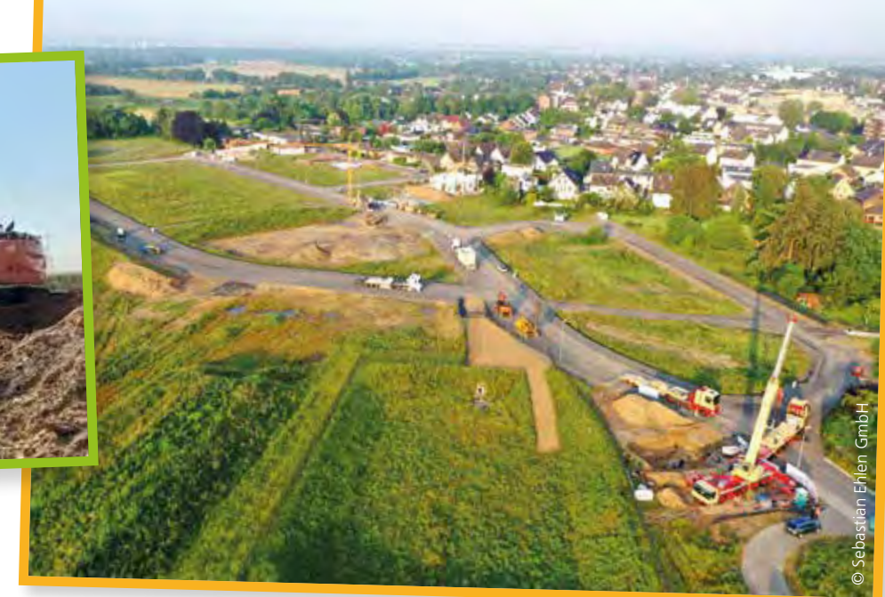
Die Stadtwerke Troisdorf realisieren im Neubaugebiet Auf dem Grend bereits ihr siebtes großes Geothermienetz, womit sie aktiv einen Beitrag zur Wärmewende leisten.
