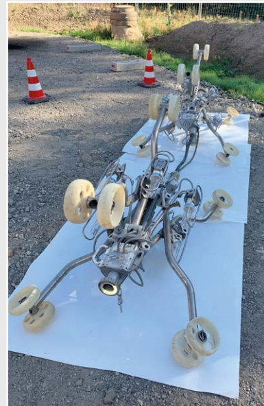
UV-Lichterkette zur Aushärtung des Liners.
