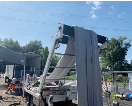
Der 200 Meter lange Liner wird eingebaut.
