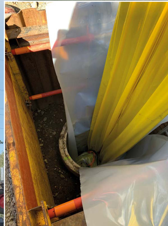
Faszinierend: Der noch schlaffe Schlauch wird in den Kanal eingezogen. Mittels Druckluft und UV-Aushärtung entsteht daraus ein statisch tragfähiges und dichtes Rohr-in-Rohr-System.
