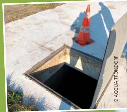
Auch die Schwallwasserbehälter müssen saniert werden.
