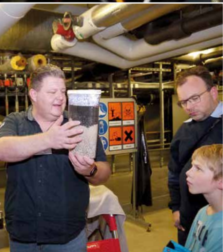
Betriebsleiter Daniel Ziegler zeigt am Modell den Aufbau der Filter, die das Wasser des Schwimmbads reinigen. Gut zu erkennen ist die schwarze Schicht der Aktivkohle.
