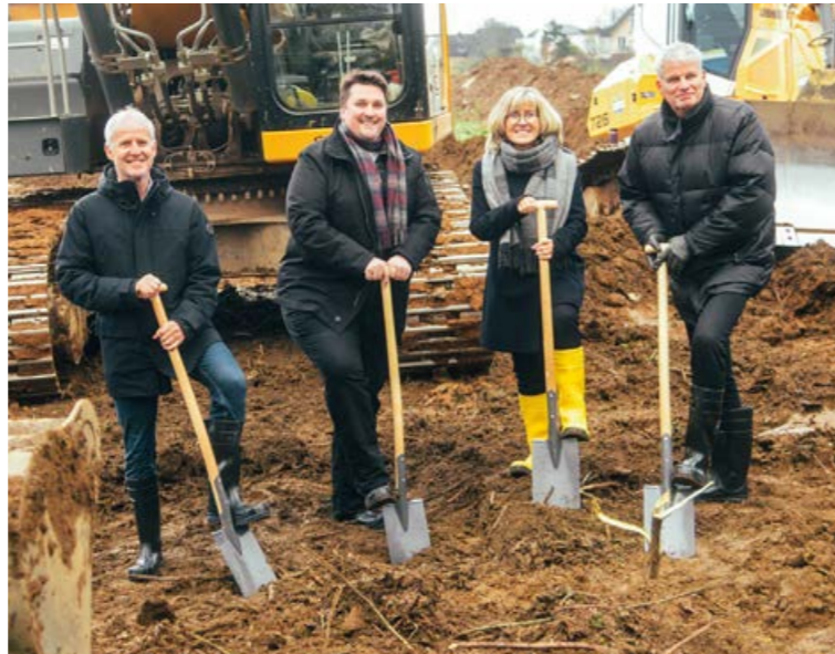
Zum offiziellen 1. Spatenstich „Auf dem Grend“ in Sieglar trafen sich der Technische Beigeordnete der Stadt Troisdorf Walter Schaaf, Bürgermeister Alexander Biber sowie die TroiKomm-Geschäftsführung Andrea Vogt und Michael Roelofs (v. l. n. r.).
