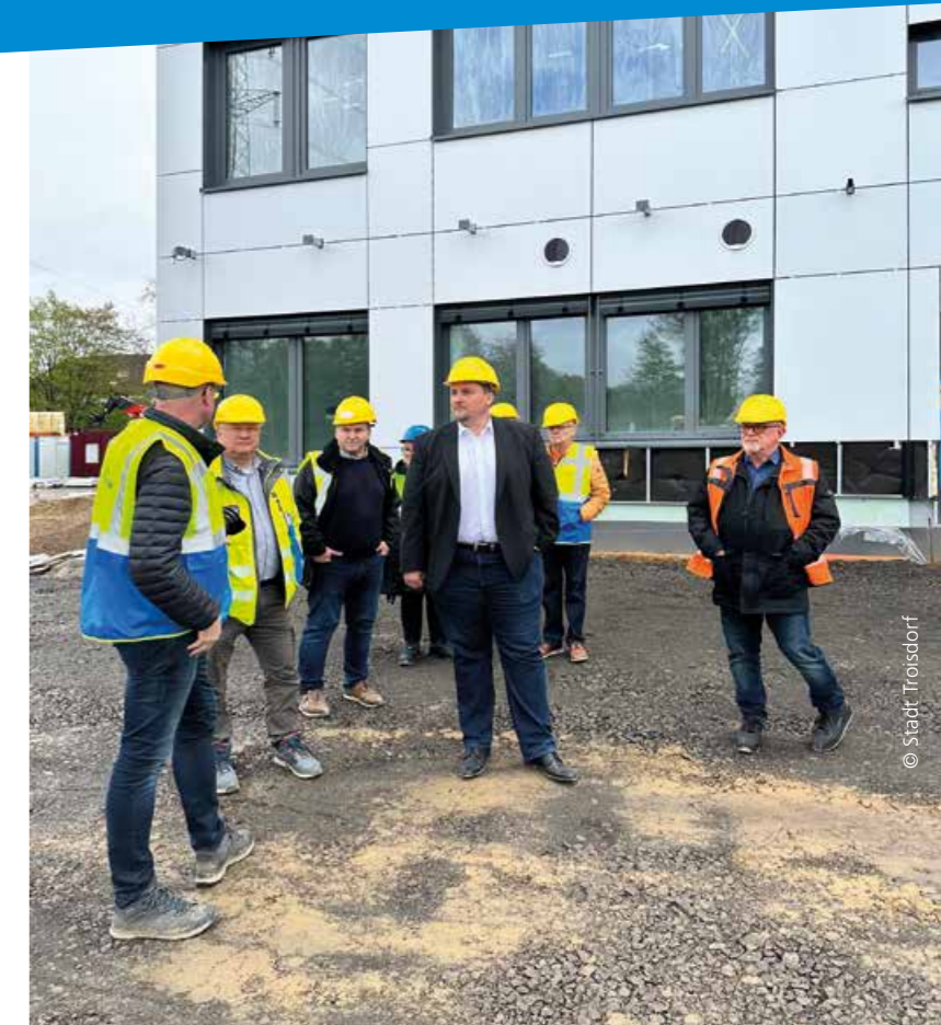
Regelmäßiger Baustellenbesuch: Bürgermeister Alexander Biber informiert sich über Fortschritte beim Neubau des Schulzentrums in Sieglar.
