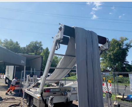
Der 200 Meter lange Liner wird eingebaut.
