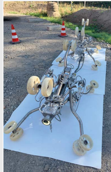
UV-Lichterkeine zur Aushärtung des Liners.
