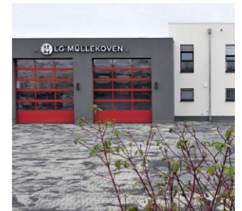
Neue Feuerwehr-Gerätehäuser Seite 08
