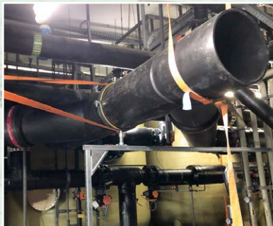
Alte Rohre raus, neue Rohre rein: Die Spülwasserleitung im AGGUA wurde komplett erneuert.
