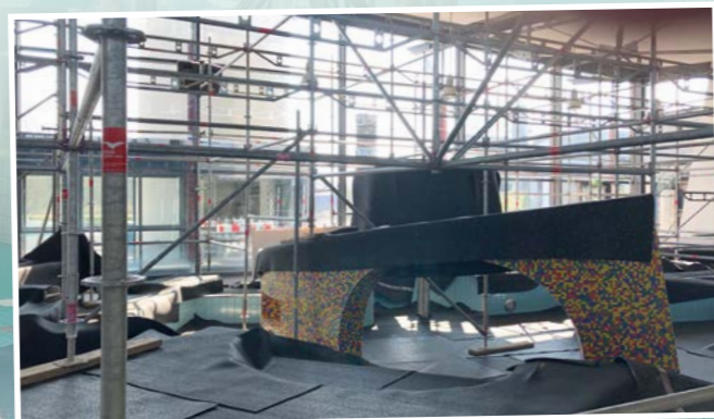
Die Reinigungs- und Sanierungsarbeiten im AGGUA dauern voraussichtlich bis zum Herbst an.
